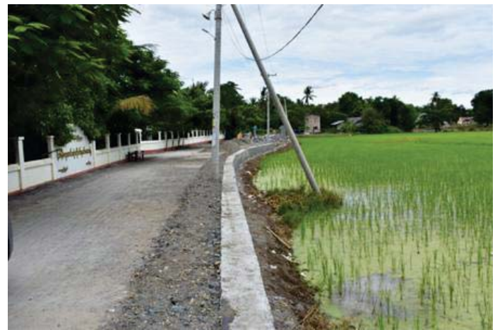
အမရပူရမြို့နယ် တမုတ်စိုးကျေးရွာ ကျောက်ရိုးစီ မြေထိန်းနံရံဆောင်ရွက်ခြင်းပြီးစီးမှု
