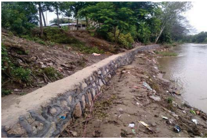
ဥတ္တရသီရိမြို့နယ် ဘုရားကုန်းကျေးရွာ ကျောက်စီ မြေထိန်းနံရံတည်ဆောက်ခြင်းလုပ်ငန်း ပြီးစီးမှု
