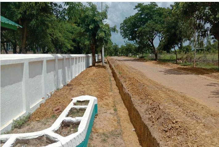
ကျွန်းလှမြို့နယ်လွှတ်တိုက်ကျေးရွာ စာသင်ကျောင်း ခြံစည်းရိုးတည်ဆောက်ခြင်းနှင့်ရေမြောင်းတူးဖော်ခြင်း
