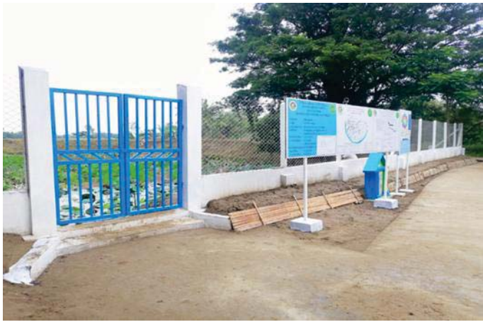
ကျောက်တန်းမြို့နယ် ညောင်ဝိုင်းလေးကျေးရွာ ရေကန်ခြံစည်းရိုး (၂)ဖက်အား Retaining Wall ပြီးစီးမှု
