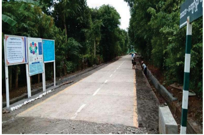
ကလေးမြို့နယ် ကျော်ရွာကျေးရွာ ကွန်ကရစ်ခင်းခြင်းလုပ်ငန်းပြီးစီးမှု
