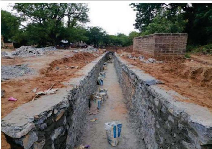
မြင်းခြံမြို့နယ် သစ်ရုံကျေးရွာ ရေမြောင်းတူး၍ ကျောက်ကြီးစီခြင်းလုပ်ငန်းဆောင်ရွက်ပြီးစီးမှု
