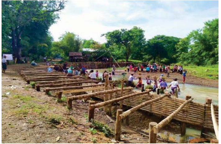
ကြံခင်းမြို့နယ် စမ်းရွာကျေးရွာ မြေထိန်းနံရံကာရံခြင်း လုပ်ငန်းဆောင်ရွက်နေခြင်း
