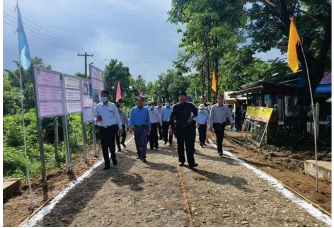
ခနုဖြူမြို့နယ် အလမျိုးကျေးရွာ ရွာတွင်း အမာခံလမ်းဆောင်ရွက်ခြင်းအား ကွင်းဆင်းခြင်း
