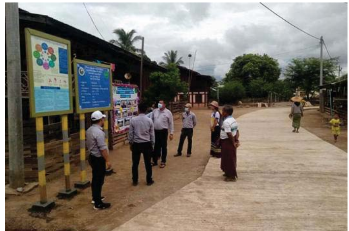
ဖားဆောင်းမြို့နယ် ဝမ်အောင်း(ကယား)ကျေးရွာ ကွန်ကရစ်လမ်းခင်းခြင်းလုပ်ငန်းပြီးစီးမှုကွင်းဆင်းခြင်း
