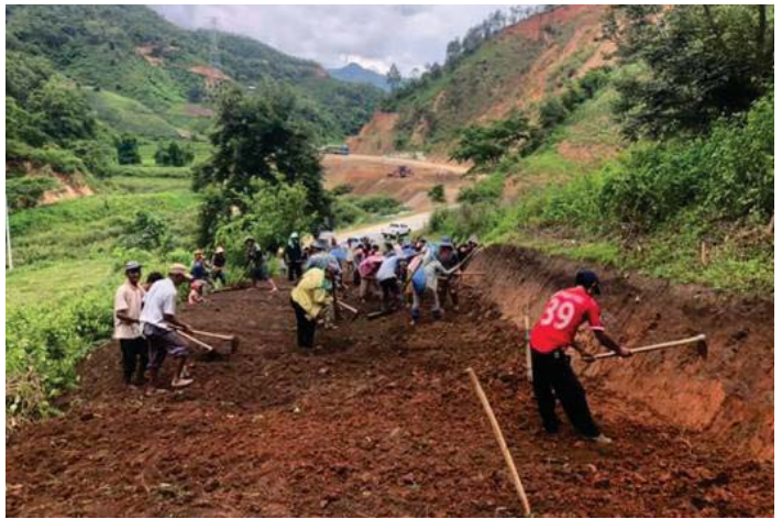
ကျိုင်းတုံမြို့နယ် ပန်ဆန်းကျေးရွာ ကျေးရွာအဝင်လမ်းဆောင်ရွက်နေခြင်း
