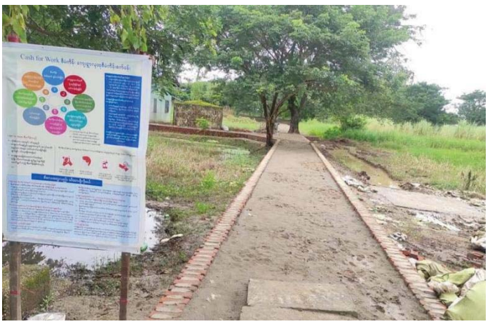
တွံတေးမြို့နယ် တူးချောင်းလေးကျေးရွာ အုတ်ရိုးစီ အလယ်မြေသားထည့်သံဖြည့်ခြင်းလုပ်ငန်းပြီးစီးမှု
