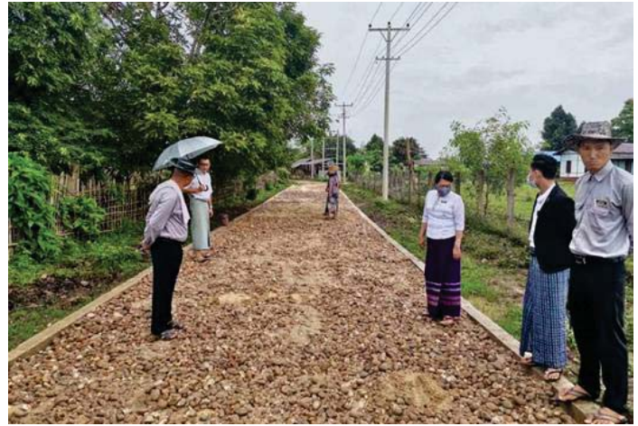
ဗန်းမော်မြို့နယ် မြလယ်ကျေးရွာ ရွာတွင်းကွန်ကရစ် ဘောင်ဖြင့်ကျောက်ချောလမ်းခင်းခြင်းပြီးစီးမှု
