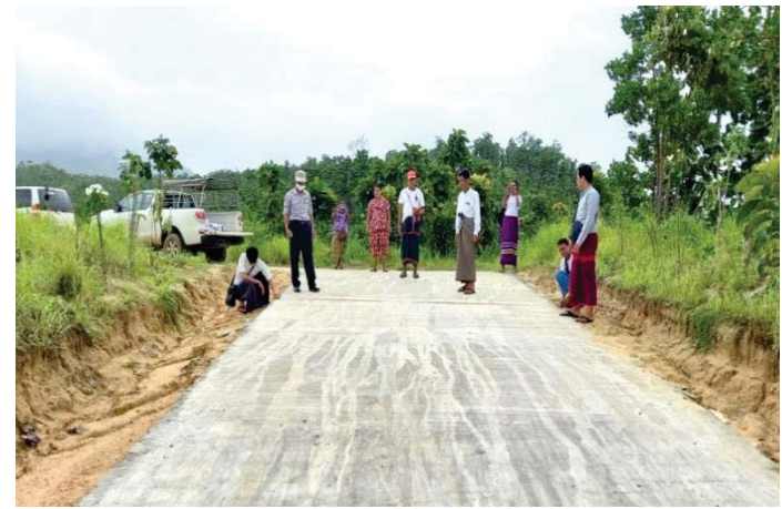
မြဝတီမြို့နယ်၊ လေးကော့ကျေးရွာ ကွန်ကရစ်လမ်းခင်းခြင်းပြီးစီးမှု ကွင်းဆင်းခြင်း
