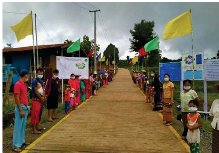
ကျောက်မဲမြို့နယ် ကျောက်မဲကြီးကျေးရွာ ကွန်ကရစ်လမ်းခင်းခြင်းဆောင်ရွက်ပြီးစီးမှု
