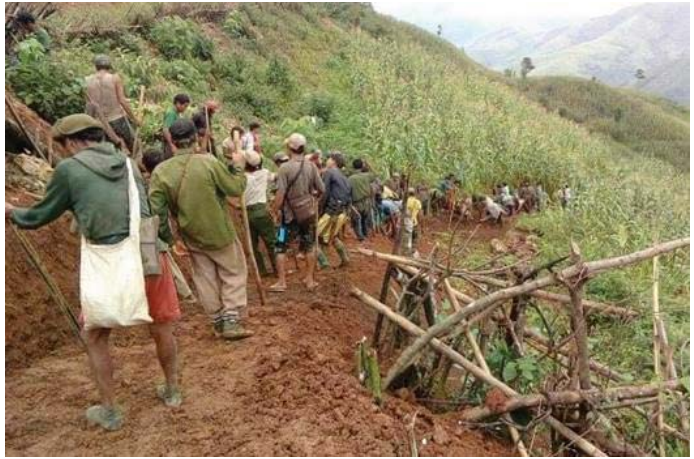
လဟယ်မြို့နယ် စံတုံနောက်အင်းကျေးရွာ ဆိုင်ကယ်ပတ်လမ်းဆောင်ရွက်နေခြင်း
