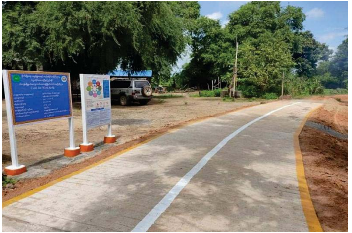
သဲကုန်းမြို့နယ် ဘိုကုန်းကျေးရွာ ရွာတွင်းကွန်ကရစ်လမ်းဆောင်ရွက်ပြီးစီးမှု
