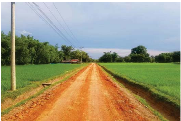
မြဝတီမြို့နယ်၊ လေးကော့ကျေးရွာ ကွန်ကရစ်လမ်းခင်းခြင်းပြီးစီးမှု ကွင်းဆင်းခြင်း
