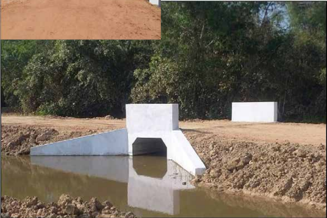
တိုက်ကြီးမြို့နယ်၊ သာယာကုန်းကျေးရွာ ကုန်ထုတ်လမ်းပေါ်ရှိ Box Culvert တံတား
