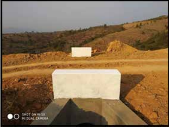
လားရှိုးမြို့နယ်၊ မန်းနားကျေးရွာ ကုန်ထုတ်လမ်းပေါ်ရှိ Pipe Culvert
